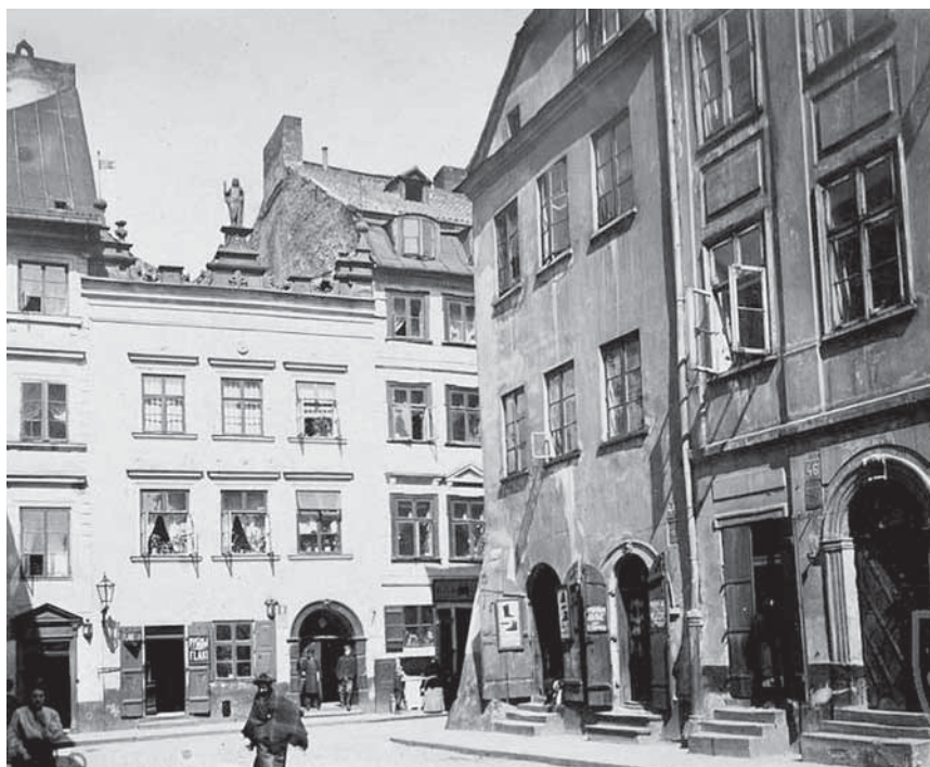
Ilustracja 1-58. Warszawa, Stare Miasto — dom „pod św. Anną”, dom tylny elewacja od ul. Piwnej. Stan przed 1916 rokiem. Zb. IS PAN, sygn. IS_PAN_BR0000006417
