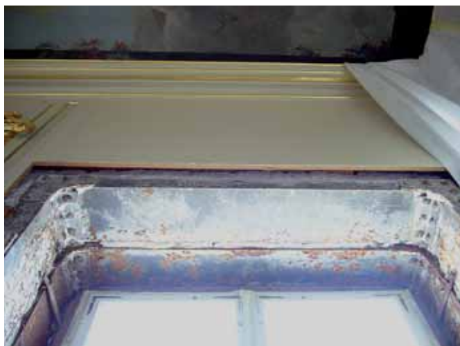
Ilustracja 1-7. Pałac w Wilanowie — korpus główny, dawny Gabinet Holenderski zwany też Pokojem Środkowym. Ramy z ceowników żelaznych osadzone około 1893 roku w ościeżach portfenetrów wg projektu Władysława Marconiego. Stan w 2008 roku: A — stan przed konserwacją; B — stan po konserwacji. A, B — fot. M. Rozbicka
