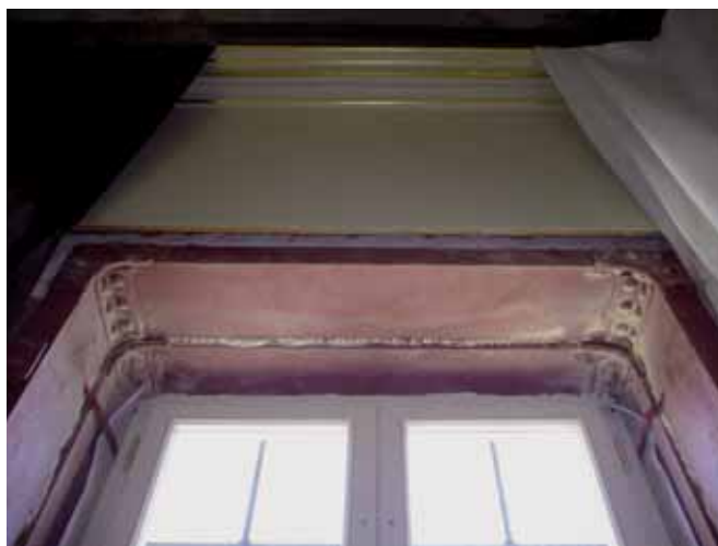
Ilustracja 1-7. Pałac w Wilanowie — korpus główny, dawny Gabinet Holenderski zwany też Pokojem Środkowym. Ramy z ceowników żelaznych osadzone około 1893 roku w ościeżach portfenetrów wg projektu Władysława Marconiego. Stan w 2008 roku: A — stan przed konserwacją; B — stan po konserwacji. A, B — fot. M. Rozbicka
