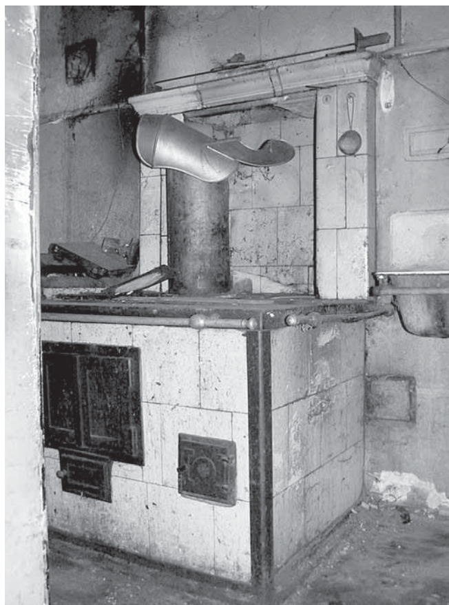
Ilustracja 2-12. Kuchnia kaflowa w kamienicy przy ul. Mokotowskiej 57 / hip. 1664 (1902). Fot. P. Kilanowski
