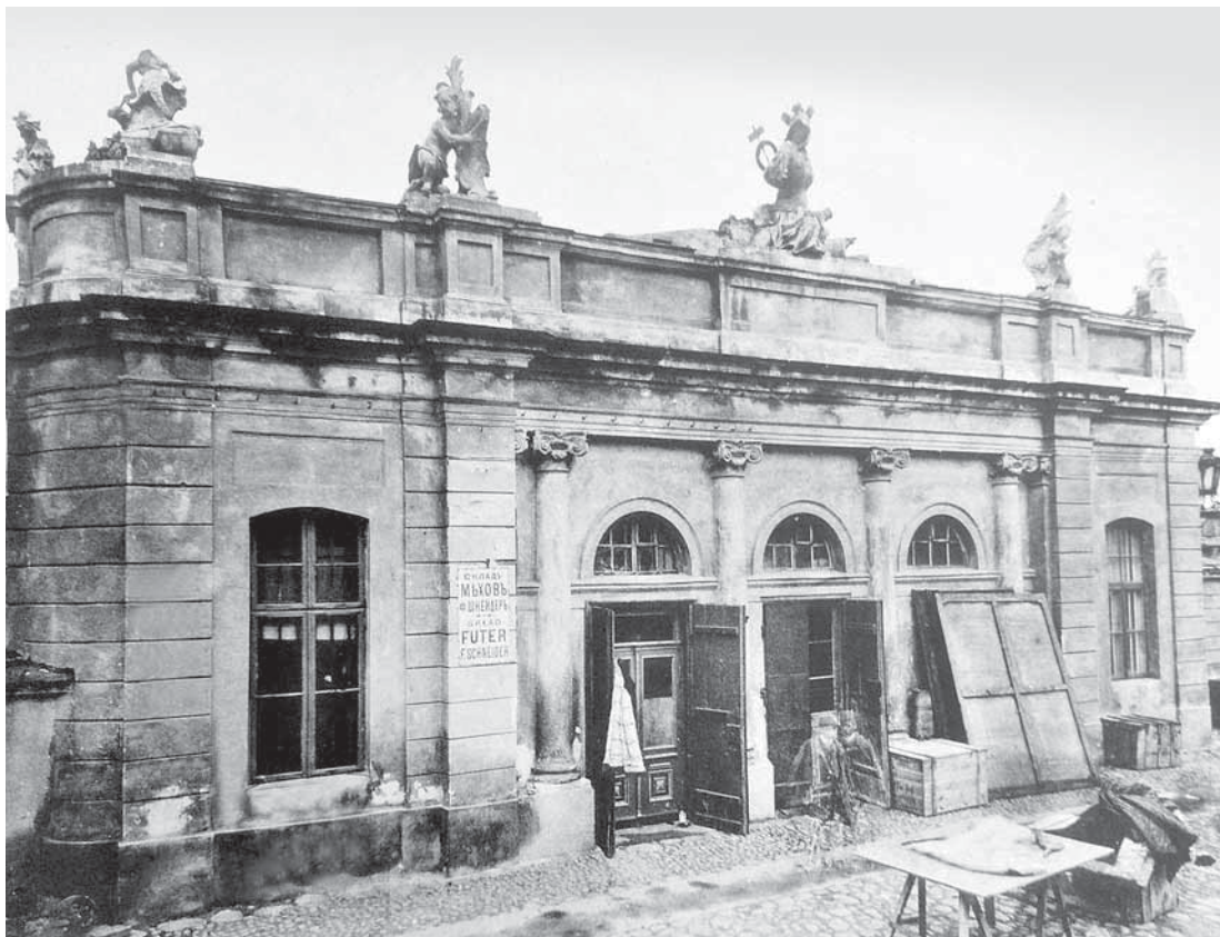
Ilustracja 1-14. Warszawa, ul. Krakowskie Przedmieście — kordegarda pałacu Potockich, widok od strony dziedzińca. Stan około 1896 roku. Fot. W. Marconi, wg: W. Marconi, Album architektoniczny dawnych zabytków i pamiątek przeszłości , Warszawa 1894–1900, z. III
