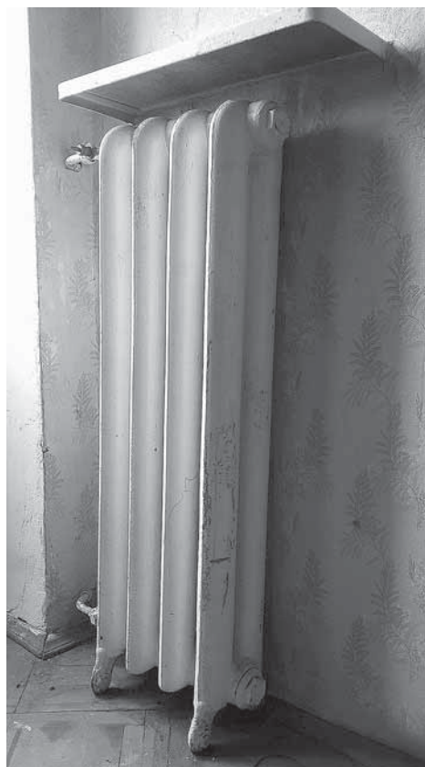
Ilustracja 2-17. Jeden z oryginalnych żeliwnych grzejników zachowany wewnątrz kamienicy przy Al. Jerozolimskich 57 / hip. 1582 EA-3 (1910). Fot. J. Rembiewska
