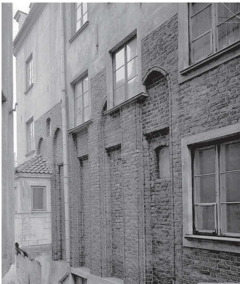
Ilustracja 1-59. Warszawa, Stare Miasto — dom „pod św. Anną”, fragment odrestaurowanej elewacji od strony ul. Wąski Dunaj. Stan przed 1937 rokiem. Fot. S. Rakowski. Zb. IS PAN, sygn. IS_PAN_B0000006382b
