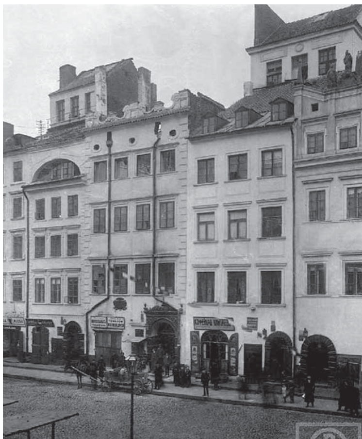
Ilustracja 1-50. Warszawa, Stare Miasto — dom Baryczków, elewacja frontowa: A — stan przed restauracją około 1911 roku. Fot. S. Pronaszko [?]; B — stan po restauracji około 1912 roku. A — Zb. IS PAN, sygn. IS_PAN_B0000006814; B — Zb. Biblioteki Narodowej (BN)
