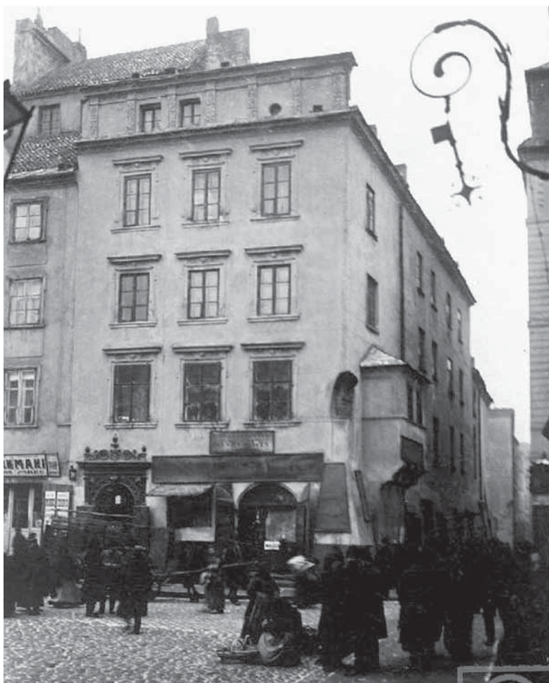
Ilustracja 1-51. Warszawa, Stare Miasto — dom „pod św. Anną”, elewacja frontowa. Stan przed restauracją około 1913 roku. Fot. S. Rakowski [?]. Zb. IS PAN, sygn. IS_PAN_B0000006817
