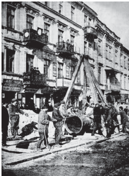
Ilustracja 2-8 (z lewej). Montaż rurociągu wodociągowego w ciągu nieustalonej ulicy warszawskiej. Wg: Wodociągi Warszawskie , Zbiór Walerego Przyborowskiego, Zb. APW, nr zespołu 202, t. 11, s. 111
